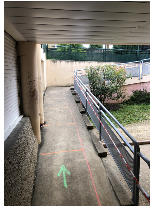
Dans le sol des marquages pour les distances de sécurité
